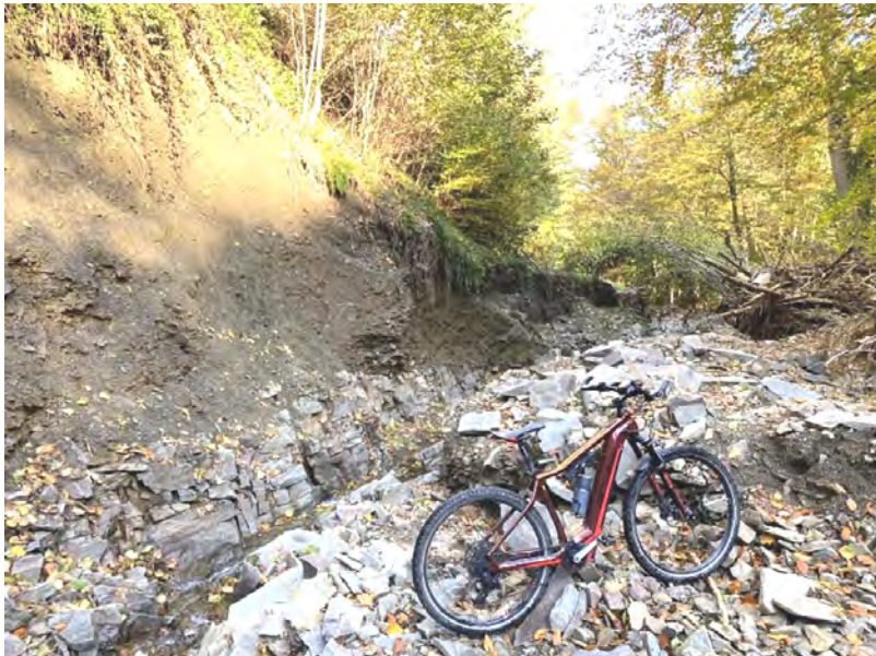
Fährtbach unterhalb von Kahlschlagflächen, in denen die Bäume in vertikal verlaufende Rückegassen geerntet und abtransportiert wurden (Foto: A. Welzel). Über Artenvielfalt im Gewässer braucht man sich hier vorerst keine Gedanken mehr zu machen.
