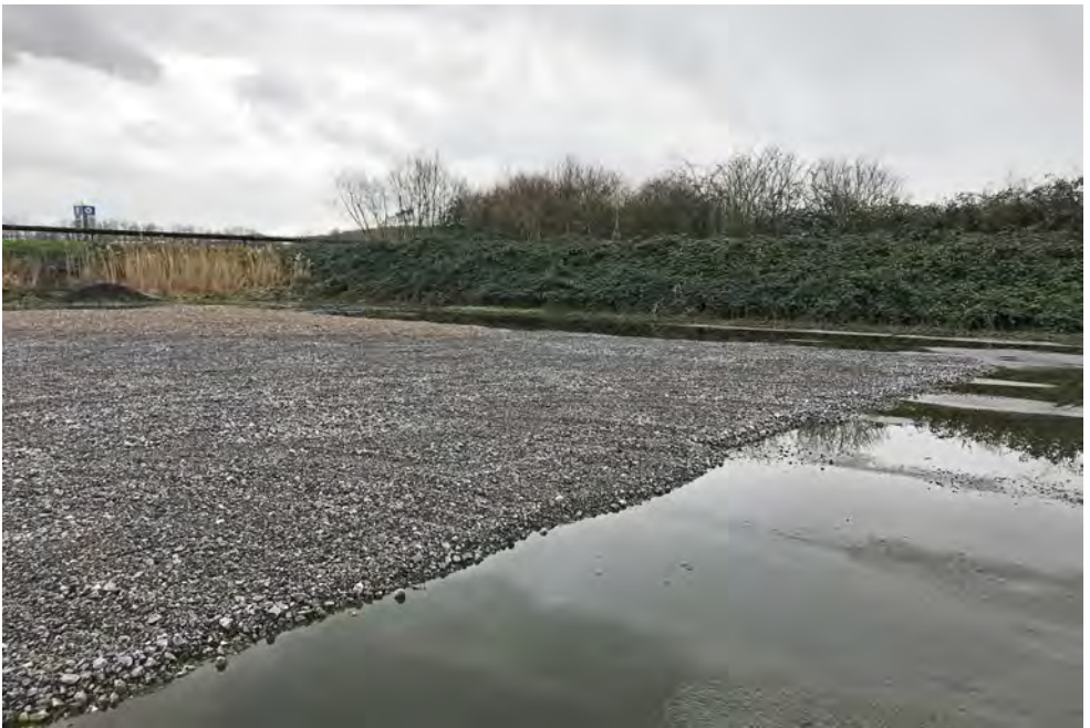
Die frisch angelegte Schotterfläche am 9. Mrz 2020
